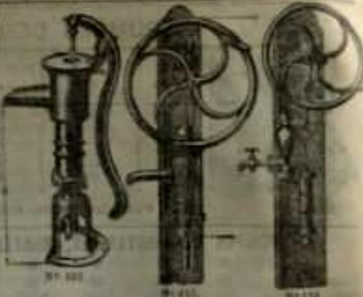
Pompe aspirante n° 101 en fonte, modèle ancien, pour puits de 10 mètres.
